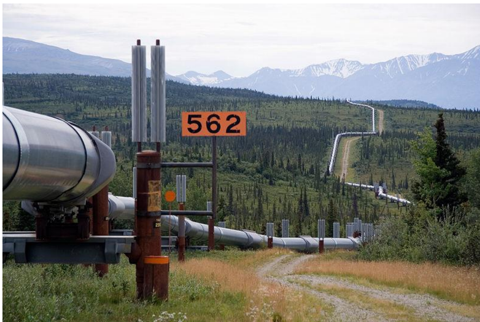
Rys. 12. Widok rurociągu alaskańskiego z zainstalowanymi w gruncie rurkami ciepła [13]
