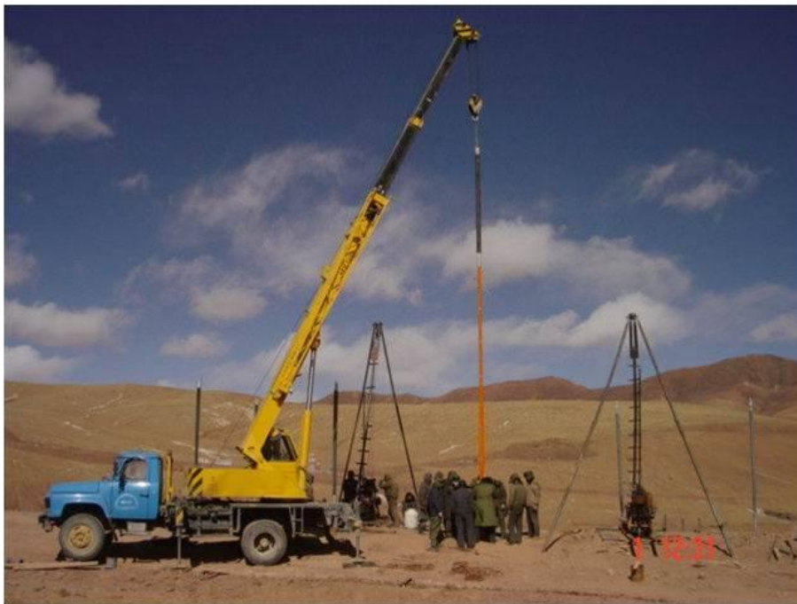
Rys. 10. Instalowania rurek ciepła [10]
