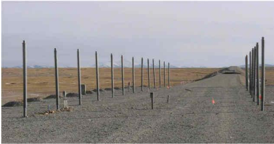
Rys. 9. Widok wystających ponad powierzchnię gruntu sekcji skraplających rurek ciepła w trakcie budowy linii kolejowej w Chinach [10]
