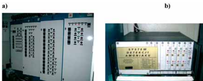
Rys. 12. Sterownia chłodnicza w OSM Kolno [6]: a) szafki sterownicze, b) detektor amoniaku
