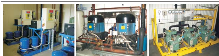
Rys. 3 Przykładowe sekcje sprężarek systemów chłodniczych dojrzewalni bananów [5,6]
