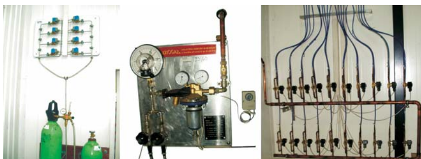
Rys. 5 Przykłady sekcji etylenowania [5,6]: a) widok butli z dozownikiem, b) dozownik, c) zawory odcinające
