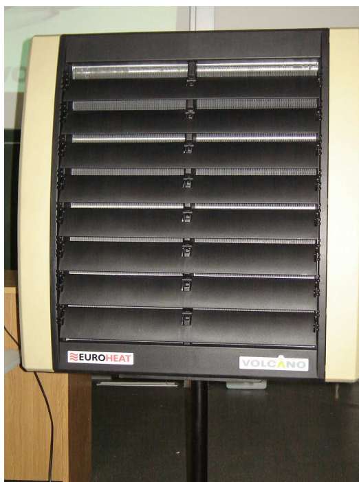
Fot. 2. Aparat grzewczo-wentylacyjny Volcano VR w estetycznej obudowie zamkniętej przestawialnymi kierownicami powietrza kryje lamelowany wymiennik ciepła i wentylator
